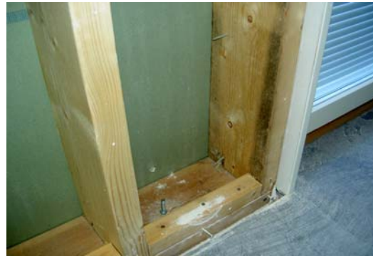
Bild 23. Angripen trärege i nyproduktion
