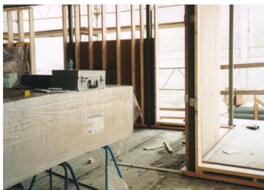
Bild 5 Gipskivor innan montering
