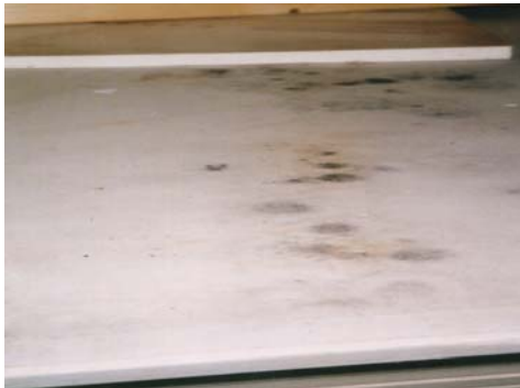
Bild 1 Mögelfläckar på pappen (kartongen) Bild 2 Rinningsmärken på skivorna
